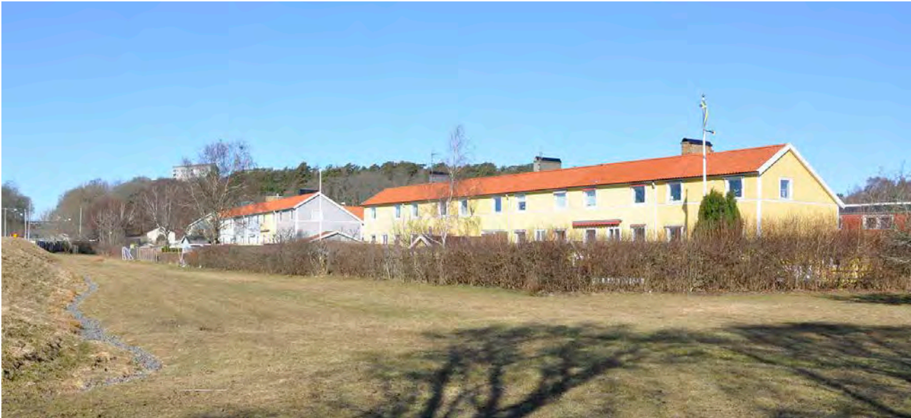
Radhusområdet norr om Radiovägen har en lummig karaktär som skapas av trädgårdarna, gräsytor och närheten till Järnbrottsskogen.
