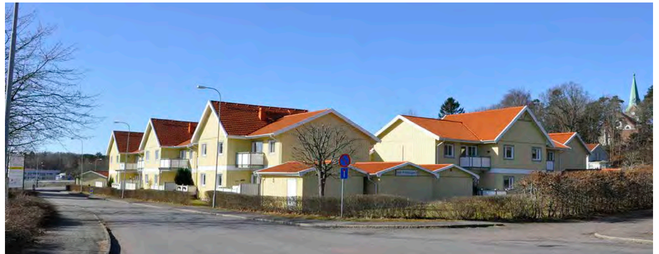
Flerbostadshus öster om Tofta Nordgård som avsevärt bryter mot den äldre bebyggelsestrukturen genom sin volym. Till höger i bild skymtar Västra Frölunda kyrka fram.
