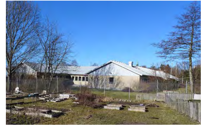
Kontorslängor med prefabricerade fasadelement som saknar det äldre områdets omsorg om detaljer.
